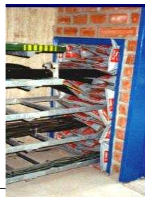
Attraversamenti di servizi tecnici
