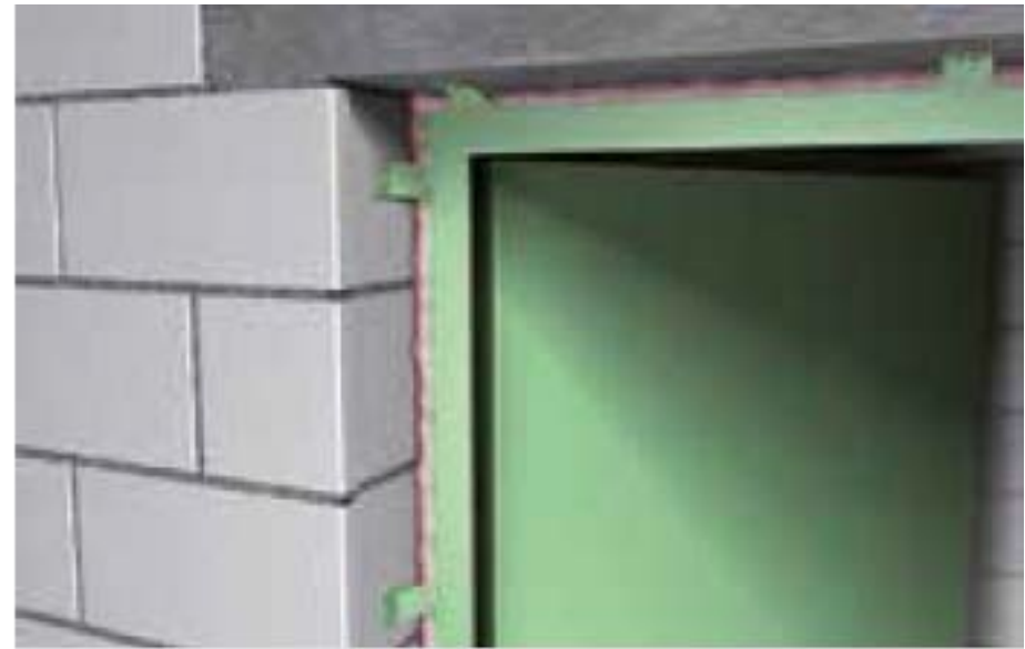
Riempimento di telai di porte
